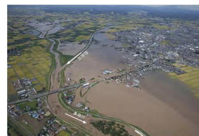
合流部での浸水状況
