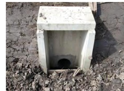
落水口の整備
