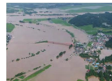
本川からの浸水状況
