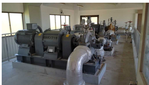
辰口寺井地区第二・配水ポンプ施設
