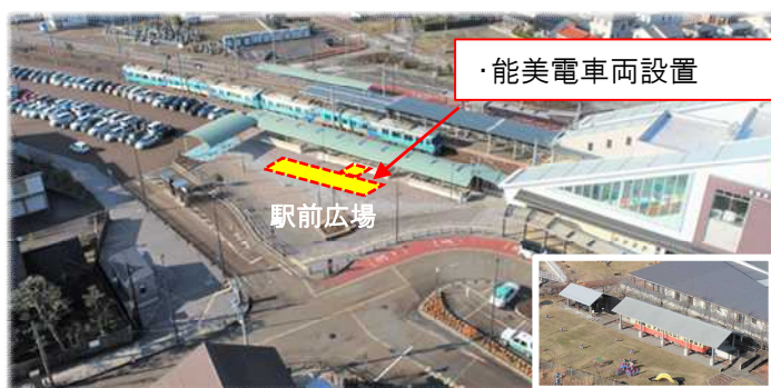
①のみ電車両を活用した無人店舗設置場所
