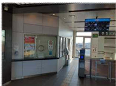
①カフェを設置する旧駅務室
