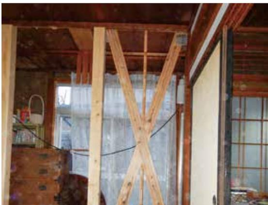
耐震改修工事(筋交いの設置)
