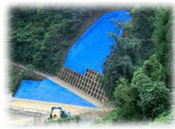
応急復旧工事後
