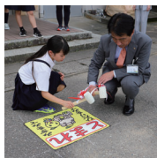
とまれシートを施工
