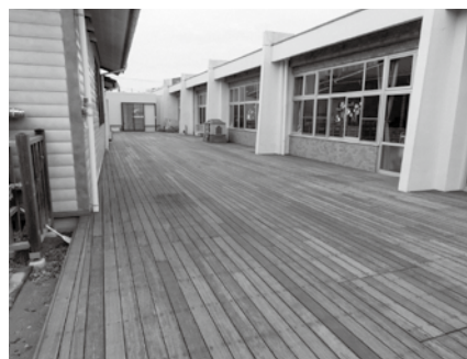
緑が丘保育園ウッドデッキ
