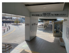
駅東口バス乗り場誘導標示 (壁面)
