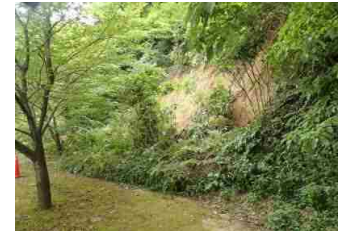
和田山古墳群の土砂崩れ
