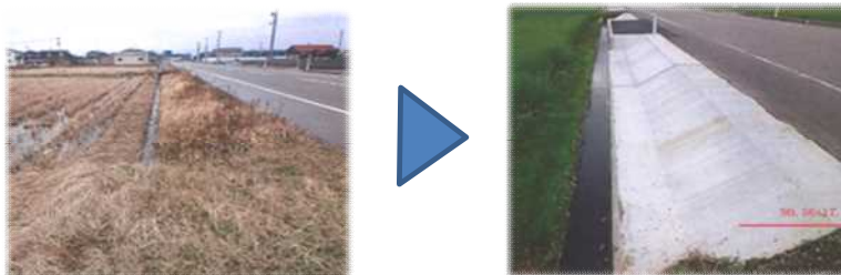
法面補修(イメージ)
