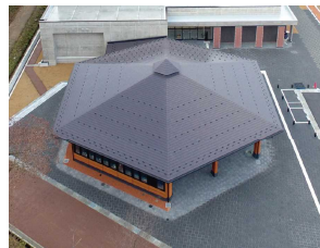
上空から見たのみふる体験棟
