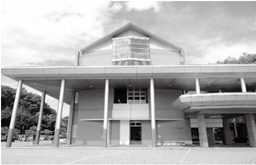
市役所本庁舎では正面入口前の駐車場整備も行われる
