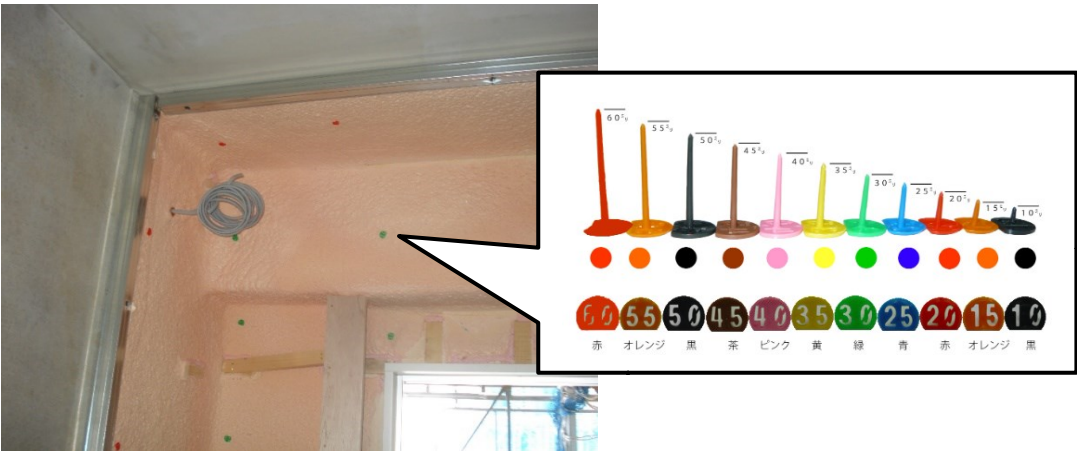
図 2-1-2 断熱材の施工写真の例（RC 共同住宅の外壁部分）
