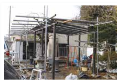
建設中の多目的スペース。ここから屋根や壁を仕上げていく予定です。今年春の完成を目指しているそうです。
