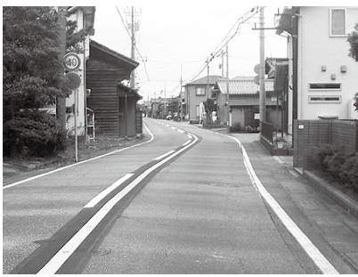
▲更新された消雪施設
