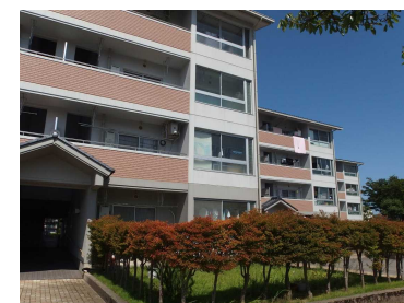
(12)-1 三ツ屋住宅 1号棟
