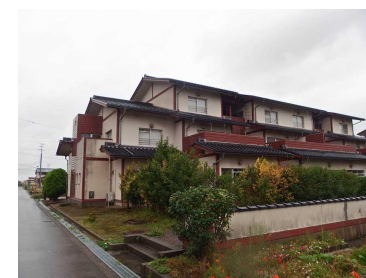
(5)-2 緑町住宅 2号棟
