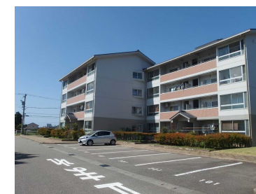
(12)-2 三ツ屋住宅 2号棟
