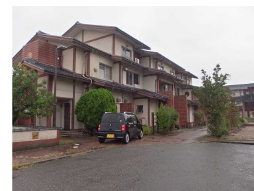
(5)-1 緑町住宅 1号棟
