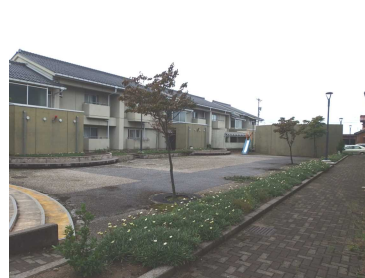
(3)-1 中ノ江住宅 1号棟
