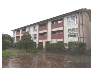
(5)-3 緑町住宅 3号棟
