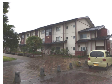
(5)-5 緑町住宅 5号棟
