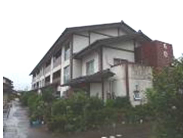
(5)-6 緑町住宅 6号棟
