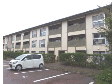
(5)-4 緑町住宅 4号棟
