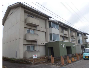
(3)-2 中ノ江住宅 2号棟
