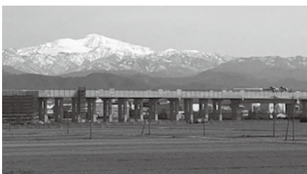
▲北陸新幹線建設工事の様子
