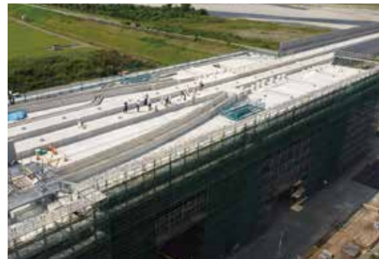
北陸新幹線高架橋を見学する参加者（ドローンで撮影）
