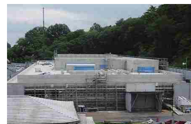
本館屋上はコンクリート型枠が外れ、壁面が完成しました。
