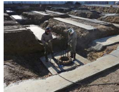
杭の頭を補強しました。
