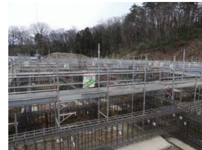
地中梁を設置しました。
