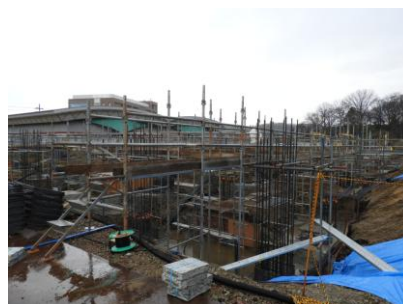
建築工事現況
