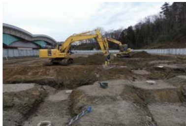
基礎・梁を施工するために地面を掘る作業です
