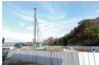
建物を支える杭を打込む作業です
