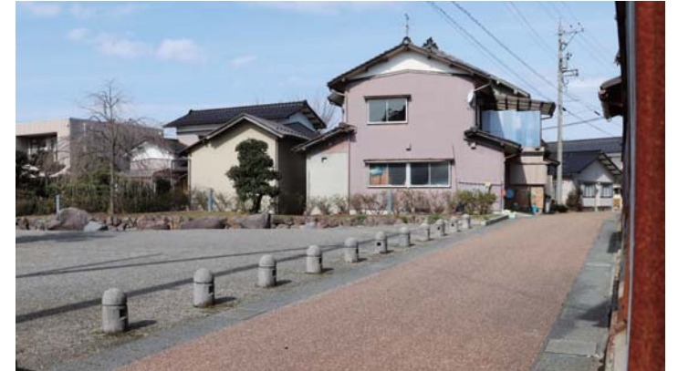
緊急時に大型車両が通行可能な道路幅に整備され、カラー舗装もされています。公園は町民が気軽に集える憩いの場となっています。
