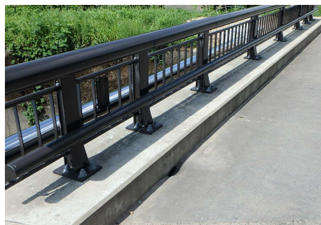
防護柵取替・地覆打換補修後の橋梁
