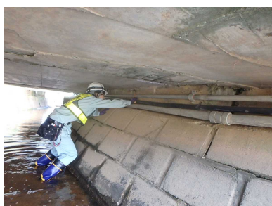
地上からの近接点検
