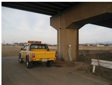
日常的な維持管理（橋下面）
