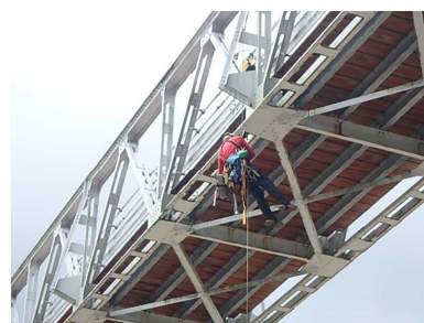
特殊高所作業による近接点検
