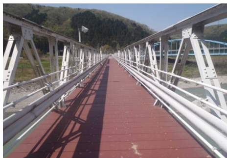
床版取替補修後の橋梁
