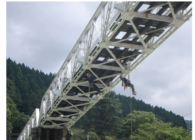
特殊高所作業による点検
