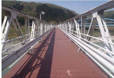
床版取替補修後の橋梁
