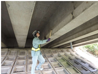
地上からの点検
