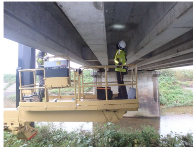
橋梁点検車を用いた点検
