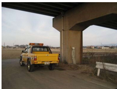
日常的な維持管理（橋下面）
