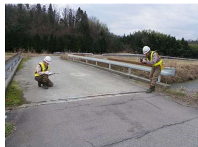
日常的な維持管理（橋上面）
