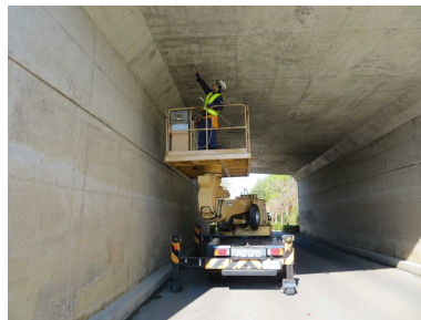
点検車を用いた点検
