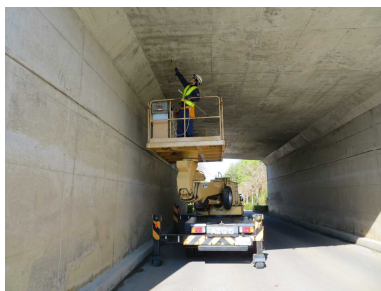
点検車を用いた点検
