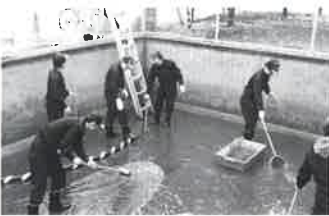
防火水槽清掃
