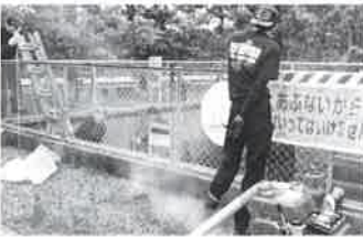
防火水槽清掃
