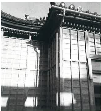
拝殿正面雨樋取付
