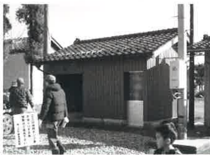
消防団ポンプ舎正面外壁張替
