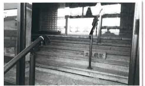
拝殿のぼり口 階段手すり2箇所設置 (1箇所は北野哲さん寄贈)
