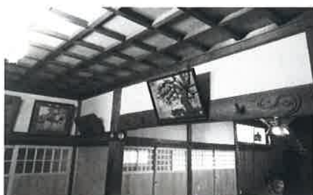
拝殿天井 張替
