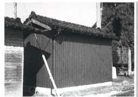
消防団ポンプ舎背面外壁張替
