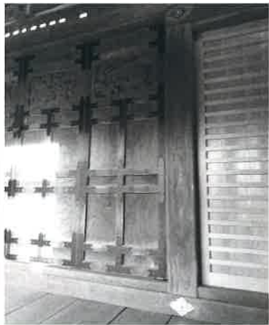
拝殿正面唐戸飾り取付 柱の六葉24箇所取り替え
