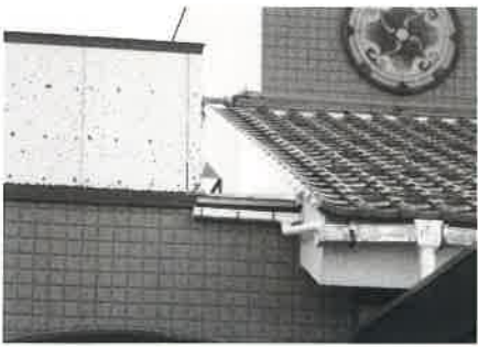
公民館外壁屋根(雨もりの改修)
