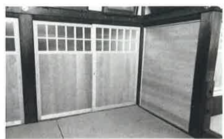
拝殿 建具取替・ 壁板張替
