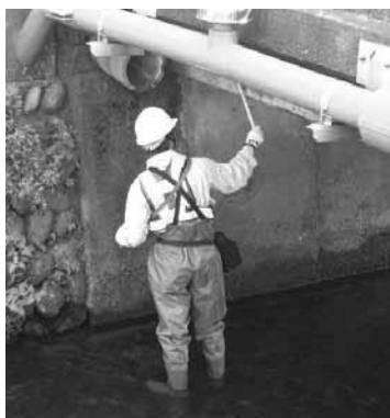
▲長寿命化計画に基づく橋梁の点検
