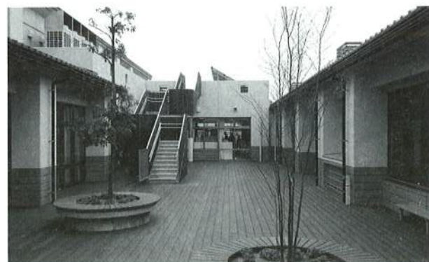
▲屋上への避難階段が整備された粟生保育園
