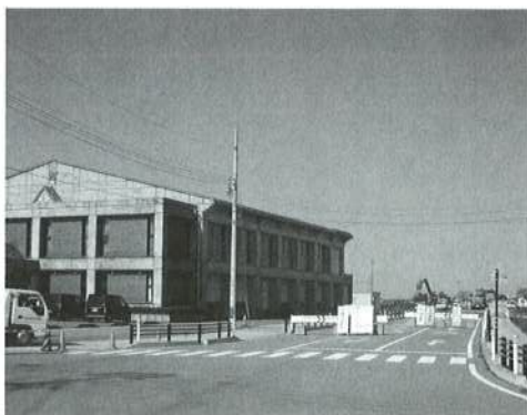
▲整備中の能美市横断道路(湯谷町地内)
