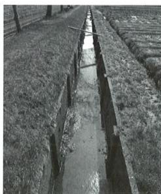
▲市内の水路写真
