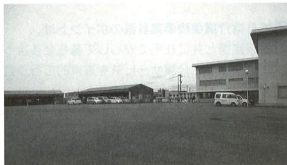
▲消防庁舎建設予定地（現ふれあいプラザ：三道山地内）
