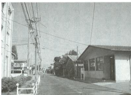
▲寺井庁舎(左)と耐震化されていない消防本部(右)
