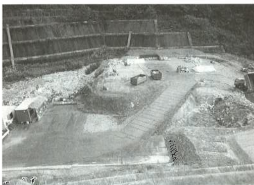
▲市民の取り組みにより延命化が図られた埋立処分場(坪野町地内)
