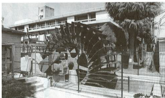
▲市役所の電力供給にも活躍する小型水力発電「元氣くん1号」（山梨県都留市）
