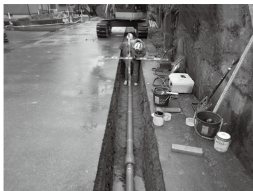
▲配水管改良工事
