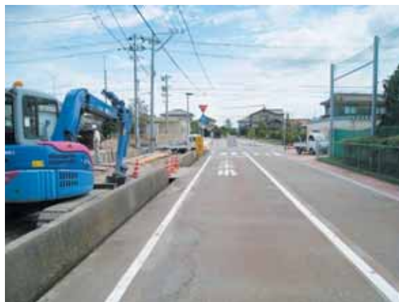
▲工事を進めている、南中央線道路
