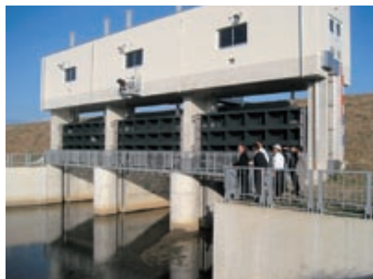
▲八木沢川樋門を視察
