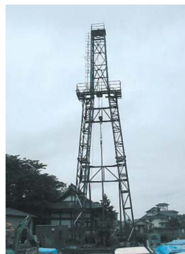
ふれあい温泉掘削中（辰口福祉会館横）▲
